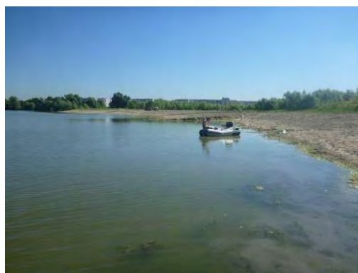
Photographie 7 : Rive sud-est en travaux de terrassement (juillet 2016)
