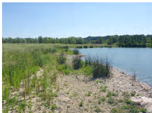
Photographie 9 : Rive sud-est de l'étang de la Vieille Ferme en phase après travaux (juillet 2019)
