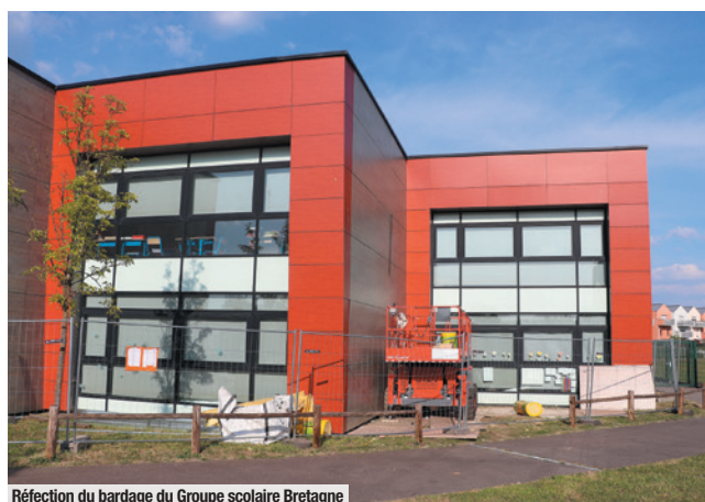
Réfection du bardage du Groupe scolaire Bretagne
